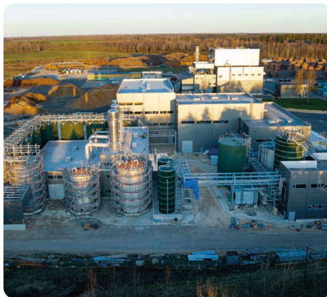
Usine de production de Fibenol à Imavere, Estonie. Capacité de 24 kT/an
